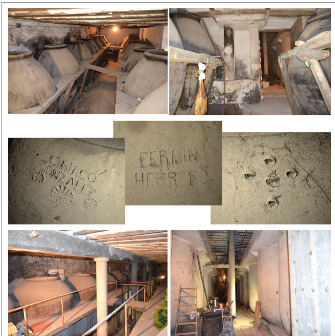
Figura 5. Vista general de la Bodega Vieja (arriba izda), cabecera prensa de viga (arriba dr), marcas de tinajero (medio) y Bodega Nueva (abajo).
